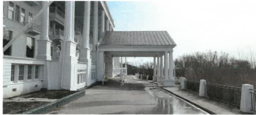
EXISTING PORTE COCHERE
